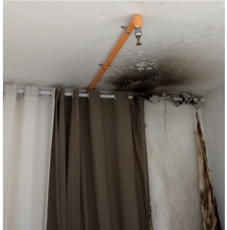
▲ Tubulação em CPVC posicionadas dentro do ambiente, mostrando a resistência do material.
